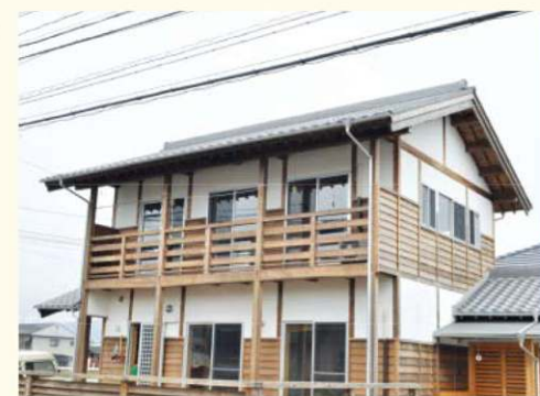
木の優しさ、暖かさを外観からも見てとれる。また床を高くし床下の換気をちゃんとしてあるので、シロアリの心配もいらない。
