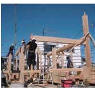
▲力強さと優美さを兼ね備え、職人技が光る丸太の木組み。完成見学会場の建て方。
