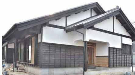
▲今回完成見学会が行われる佐賀市多布施の住宅。再利用された首の丈夫な梁と新しい梁が融合して使われ、力強さと優美さを兼ね備えた住まい。
