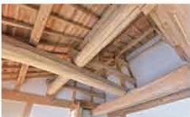
▶昔ながらの伝統工法で、新しい梁も家を支えます。
