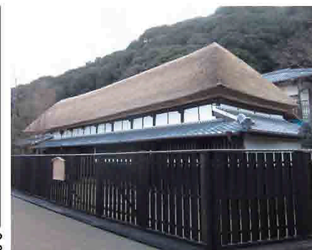
▲再生工事の本格的な葺き屋根の酒井田柿右衛門邸は趣のある造り
