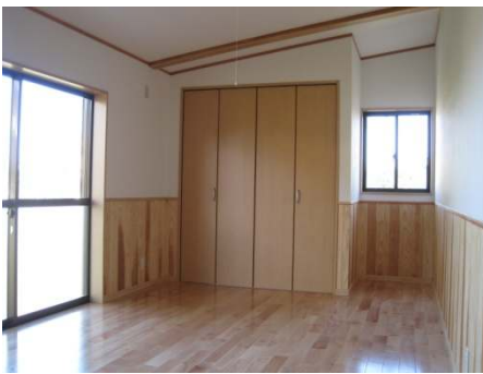
*床板、内装貼替え*
