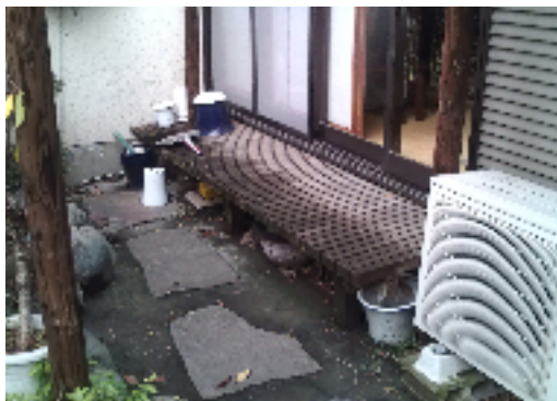
工事前のくたびれた濡れ縁
