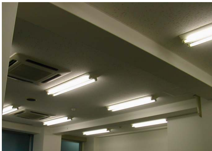
工事前の天井の状態。ごく普通の事務所天井ですね
