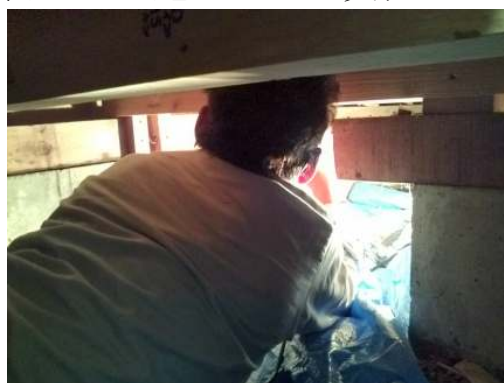
柱を確認後番号を書いて写真を撮る
