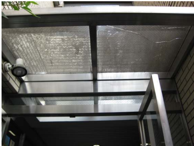
確かに熱で割れていた元の状態
