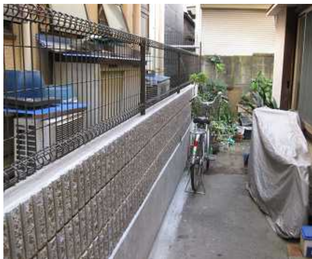
低いブロックと軽いフェンスで対策完了
