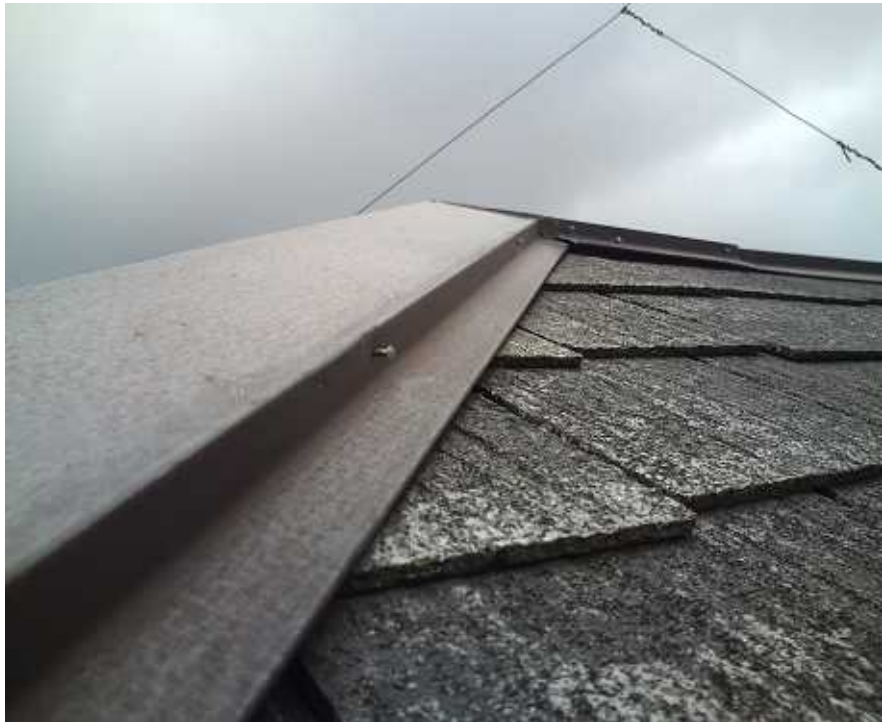
改修前の状態です。全体的に釘が浮いているのが分りますか？
