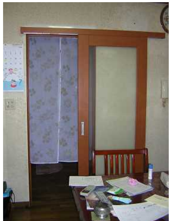
オフセット片引戸に交換完了。収まりもスツキリ
