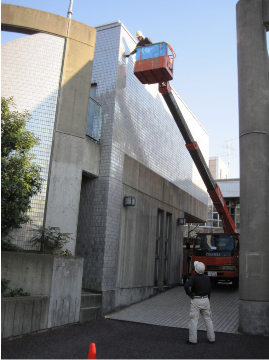
高所作業車を使って、危険な部分を調査中。
