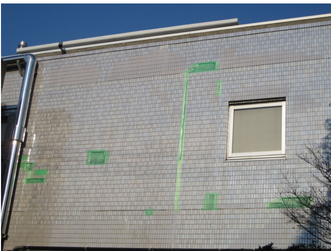
調査後に浮いていた部分を剥がした状態。結構ありましたね
