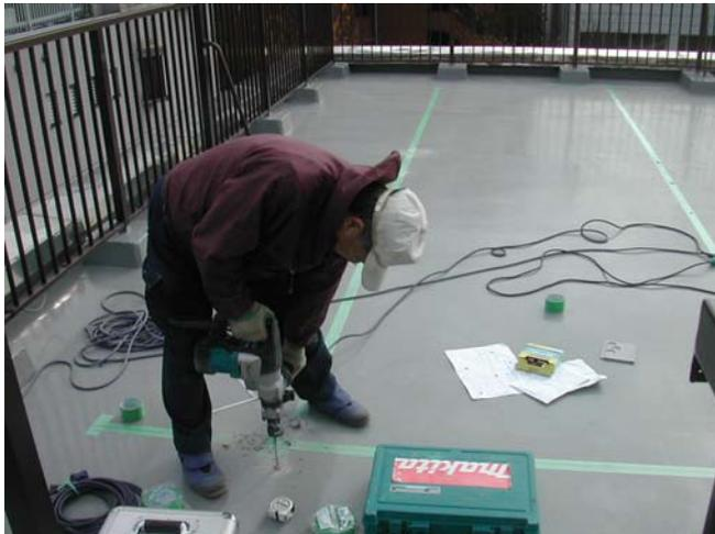
鉄筋アンカーを打ってからウレタン防水をかけます。
