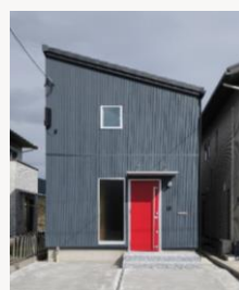
↑外壁の濃紺（アトランティックチタンブルー）に赤いドアが印象的な外観。
