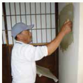
左官とは、漆喰や珪藻土、モルタルなどの材料をコテを使って壁・天井・土間などに塗る仕事です。
