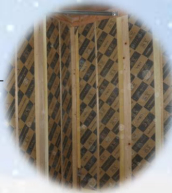
建築途中の断熱材の確認ができます◎
