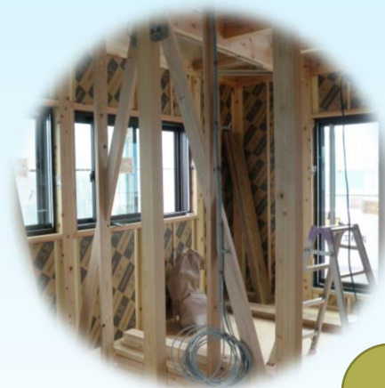
施工見学風景
