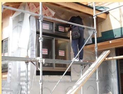
断熱材・遮熱透湿シート貼り工事完了
