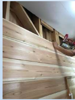
洗面所増築に伴う壁貼り工事
