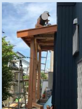
洗面所増築に伴う壁貼り工事
