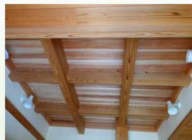
リビング天井が完成です。
