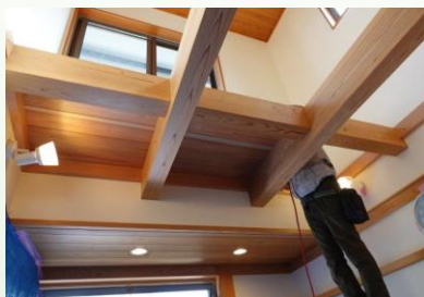
杉天井板を貼ります
