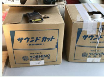
2F 床 防音 plasterボード貼り (サウンドカット+スーパーハード plasterボード)
