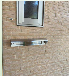
外壁 ガルバリウム鋼板・サイディング貼り工事完了
