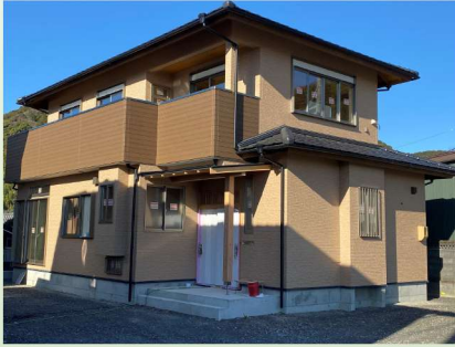
外壁 ガルバリウム鋼板・サイディング貼り工事完了
