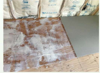
2F 床 防音 plasterボード貼り (サウンドカット+スーパーハード plasterボード)
