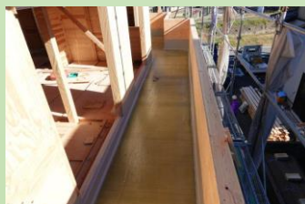
バルコニー工事
