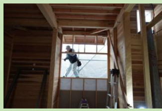
サッシ取付工事
