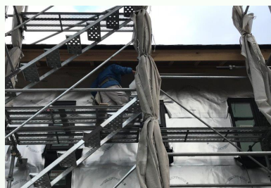
外装工事 外壁遮熱透湿シート貼り・サイディング貼り工事 外壁一郭ガルバリウム鋼板
