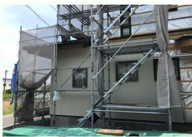
外装工事 外壁遮熱透湿シート貼り・サイディング貼り工事 外壁一郭ガルバリウム鋼板
