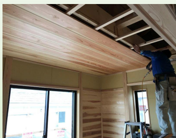
内装工事 床断熱貼り・1階リビング天井・和室天井貼り
