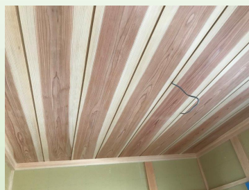
内装工事 床断熱貼り・1階リビング天井・和室天井貼り
