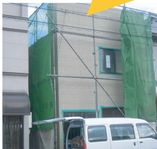
新規外壁は軽い 金属サイディング仕上げ
