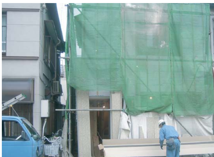
既存外壁を剥がして合板を貼る
