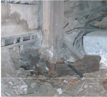
柱の腐食
