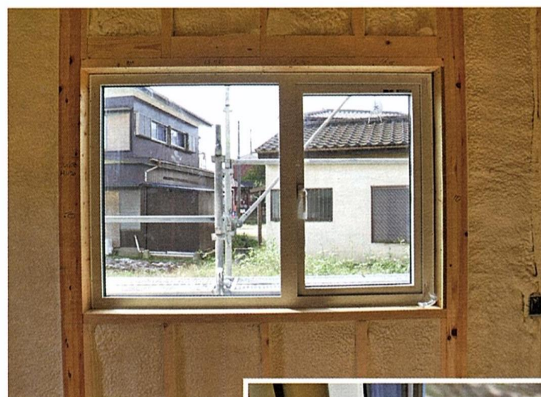
シャノンウインドSPG。一見すると普通の樹脂サッシだが、ガラスが4層（室内側が2層構成の真空断熱ガラス）になっている
