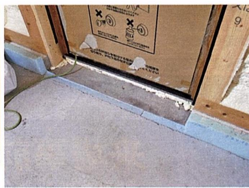
左：断熱材は現場発泡ウレタン。気密シートを断熱材で「抑え込む」ことで、気密性向上にも一役買っている 右：玄関ドア部にも切れ目なく断熱材を施工
