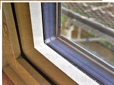
シャノンウインドSPG。一見すると普通の樹脂サッシだが、ガラスが4層（室内側が2層構成の真空断熱ガラス）になっている
