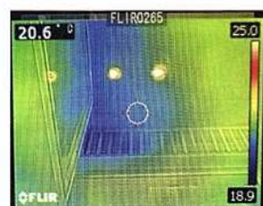
小屋裏エアコンの試験運転の様子。吹き抜けから冷気が下りてくるのがよく分かる
