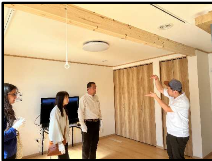
小屋裏エアコンからの冷風説明
