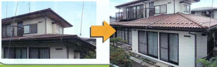
(コロニアル→洋風瓦)と外壁塗装(M邸)
