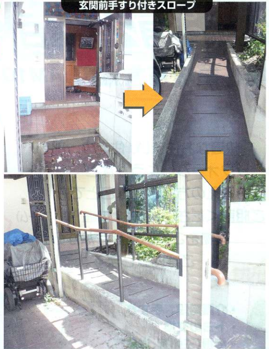
介護リフォーム 段差解消(N邸) 玄関前手すり付きスロープ
