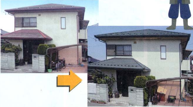
(コロニアル→洋風瓦)と外壁塗装(M邸)
