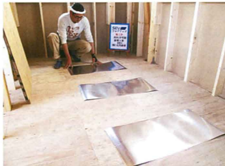
シート状のSEVを床下に敷く「SEVフロアアップ」は、畳やじゅうたん、タイルの下などでも使用可能。室内の気になる臭いなどを軽減する効果も期待できるとか。持続効果は半永久的とも。
