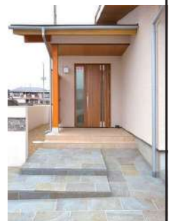
軒のある玄関。タイルも2種使用し、変化をつけた
