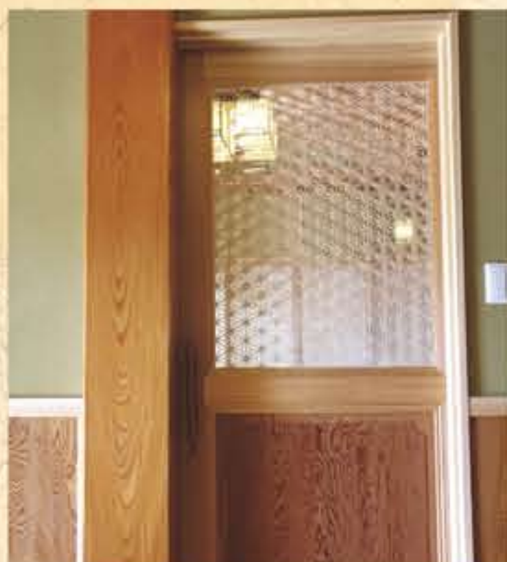
樺(尺角)の大黒柱と 組子と杉腰板の入口建具
