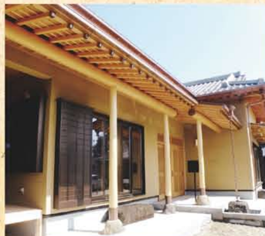
北山杉の丸桁と吉野松の丸柱 杢石には地元筑波石を使用
