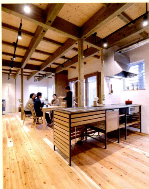
梁や柱には、くさらない木「緑の柱」を使用。その実際を見ることができる。
