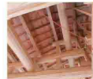
▲柱や梁など、木と木を組む伝統的な構法で、耐久性に優れた丈夫な構造になります。
