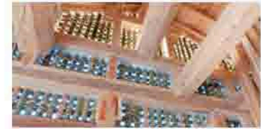
▲古民家と同じように木と竹と土を使用する事で、日本特有の湿度をコントロールし住み心地の良さを感じることが出来ます。
