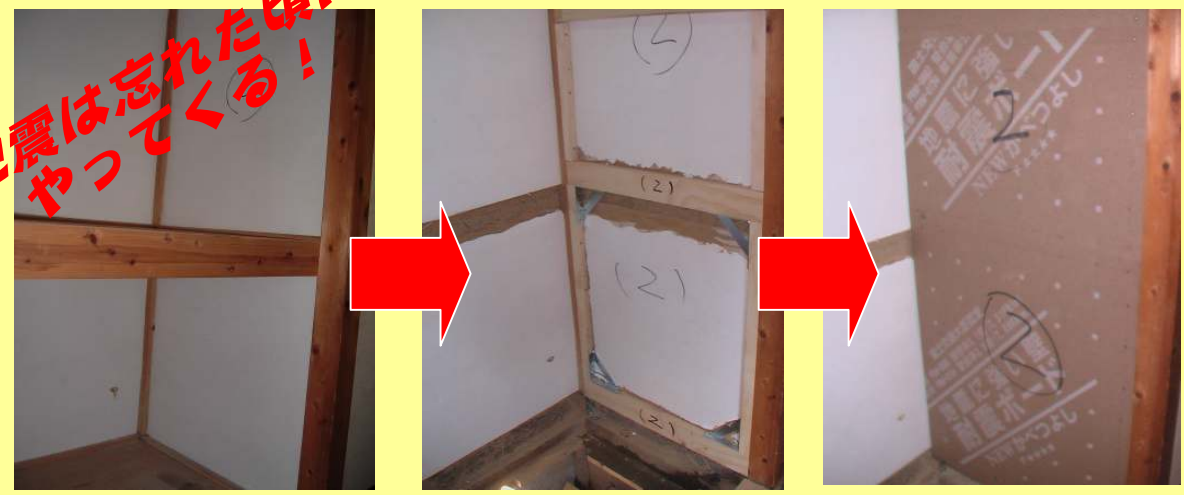
耐震補強前 耐震補強金物取付 耐震補強の耐震ボード取付
