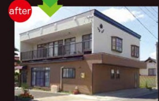
A邸 外壁サイディング貼替え工事
